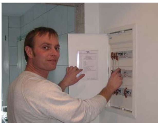
Adrian Hool bei den Fertigstellungsarbeiten im Büro der Firma Logico Solutions AG.
