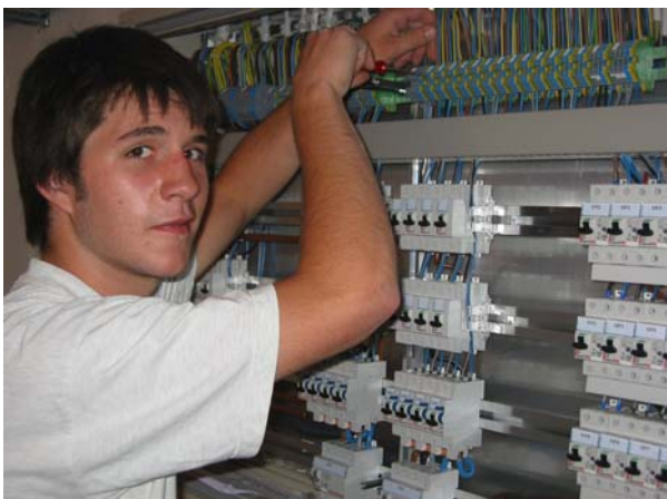
Ruckli Jonas beim Anschliessen einer Verteilung.
