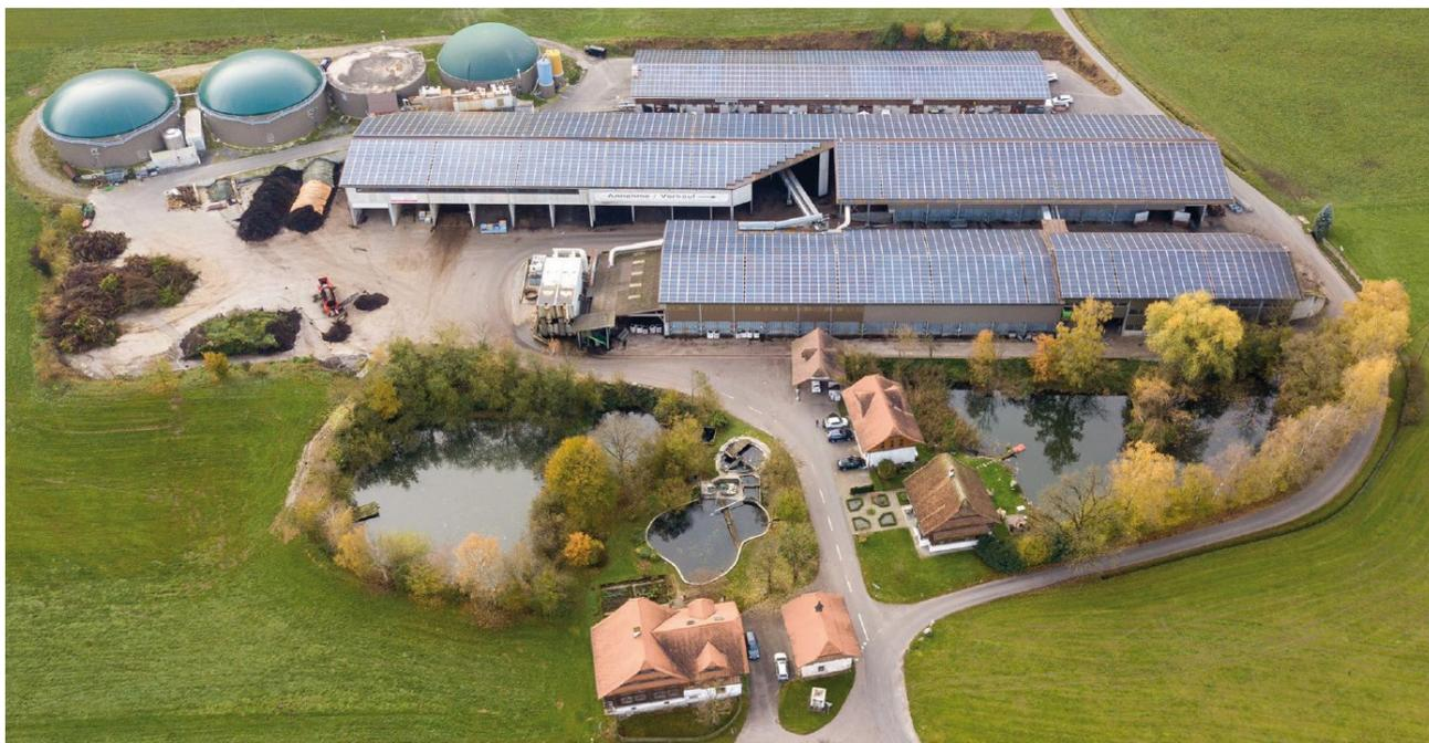
«Mit dem Einbau einer Fotovoltaikanlage ging die Weiherhus Kompost AG nun noch einen Schritt weiter», betont Eigentümer Christoph Meierhans. Die Solarzellen auf der 10'000 m<sup>2</sup> grossen Dachfläche des Kompostierwerks haben eine Leistung von 1'200 kW. Die Anlage produziert jährlich rund 1,3 Millionen kWh Strom, diese Energie wird als Eigenverbrauch für das Kompostierwerk verbraucht und der überschüssige PV-Strom wird ins Netz der Steiner Energie AG eingespeist.
