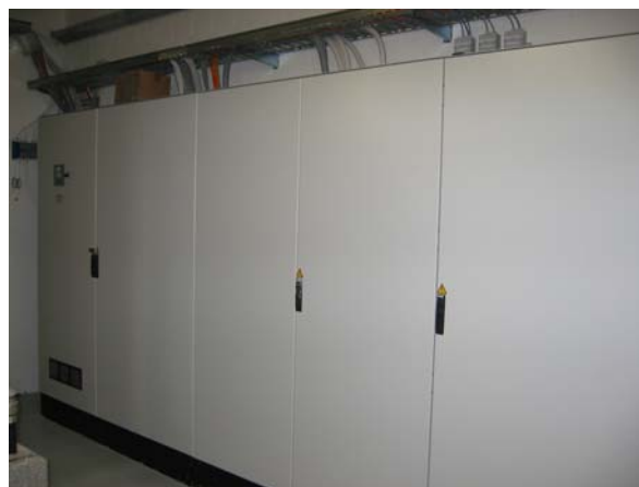
Hauptverteilung im Technikraum
