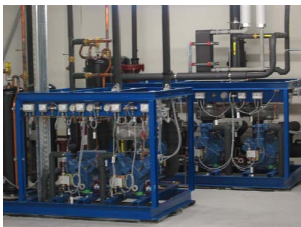
Kühlmaschinen mit 200KW Anschlussleistung
